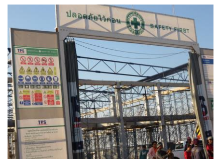
検討会に参加した T P S 社の工事現場
